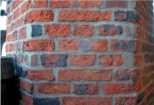
Abb. 3: Detailaufnahme des restaurierten Pfeilers im Jahre 2012 (Bürgermeister-Smidt-Gedächtniskirche in Bremerhaven)
